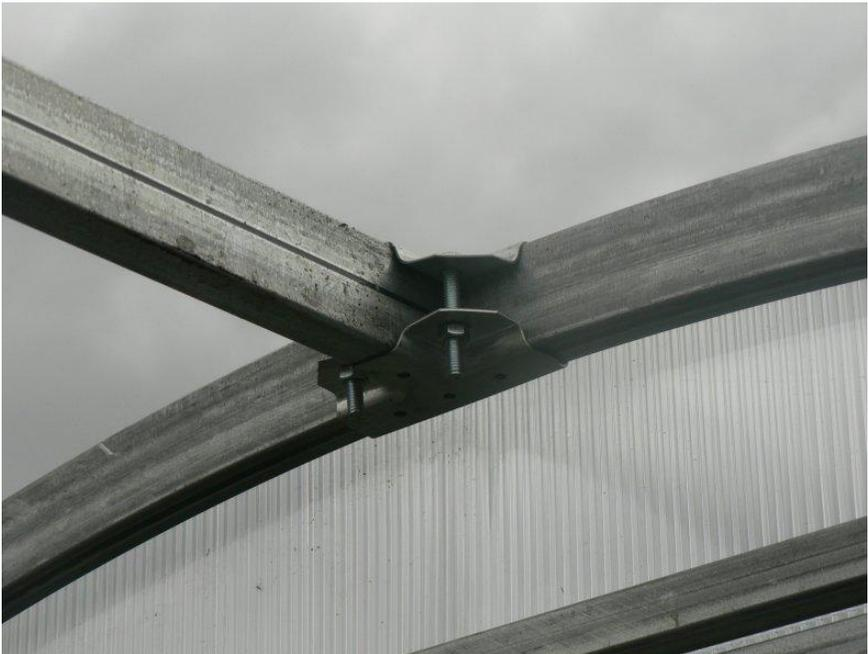
*Abb.9 Verbinden des Zwischenbogens mit der Frontseite mithilfe der Steckverbinders und Kreuzbeschlages (T-Stück)*
